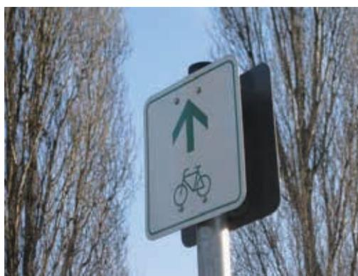
Zwischenwegweiser Rücken an Rücken, montiert, Fahrtrichtung (von beiden Seiten) weiter geradeaus
