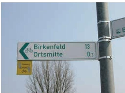
Pfeilwegweiser mit Stahlbandschellen an vorhandenem Lichtmast > 76 mm
