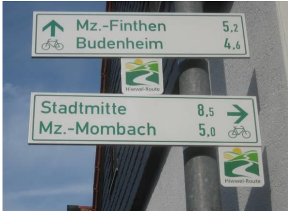
Abbildung P- 17: Montage von Tabellenwegweisern als Linksausleger
