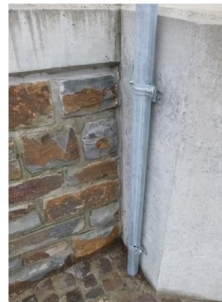
Pfosten mit Wandbefestigung bei nicht nutzbarem Untergrund
