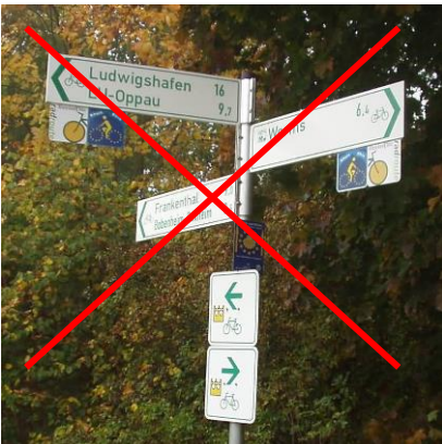
Abbildung P- 11: Nicht zulässige Montage – Beispiele
