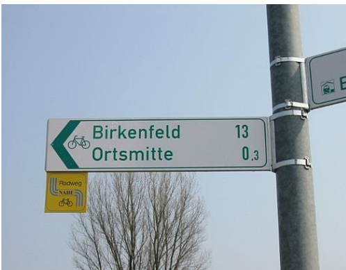
Pfeilwegweiser mit Stahlbandschellen an vorhandenem Lichtmast > 76 mm
