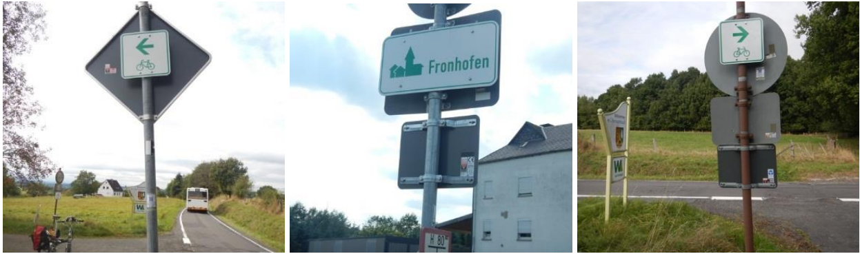
Abbildung P- 20: Montage Zwischenwegweiser und Ortseingangsschild, Beispiele
