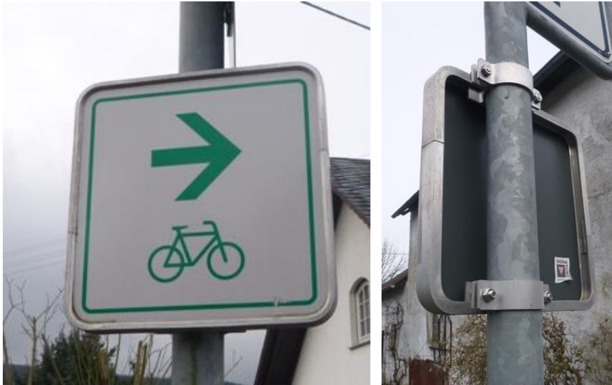
Abbildung P- 33: Zwischenwegweiser mit Rahmenverstärkung
