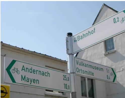
Pfeilwegweiser mit Aluklemmschellen
