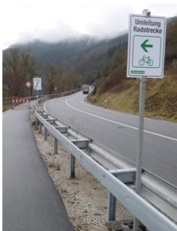
**Abbildung 38: Umleitungsschild nach HBR**
