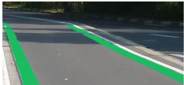
Abbildung 32 - Durchgehende farbige Randmarkierung der Pendler-Radroute; Quelle: PRR-Standard 2019 [10]
