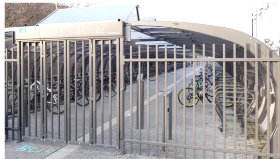
Abbildung 36 – Sammelschließanlage. Foto: VAR+
