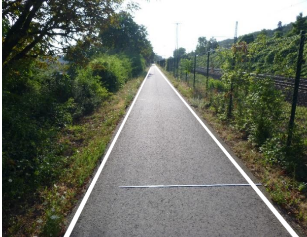
Abbildung 1: Durchgehende reflektierende Bodenmarkierung
